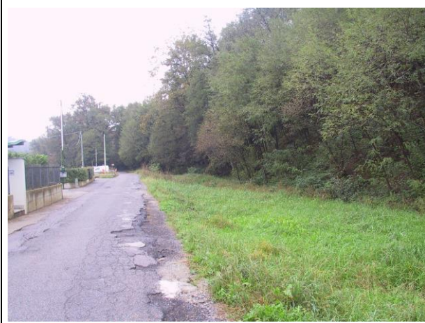
Foto 3: Aree prossime al corso d'acqua BG06 prima dell'intervento di sistemazione idraulica (ottobre 2014).
