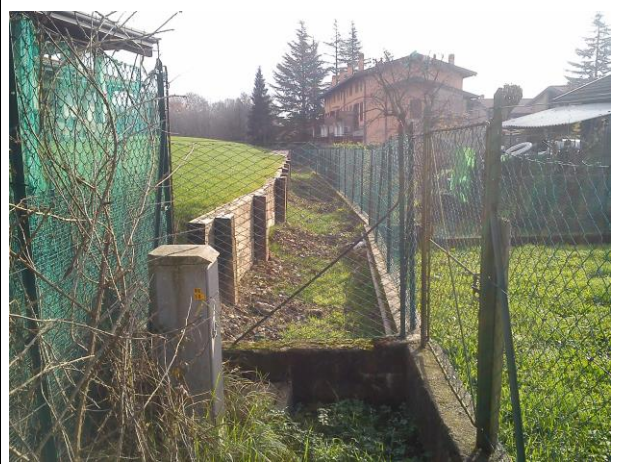
Foto 8: Tratto intubato del corso d'acqua BG30 (Fosso della Regina).
